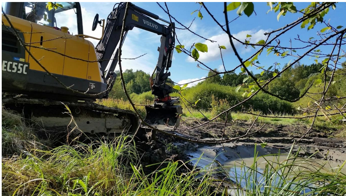
Figur 6. Grävarbete för anläggande av nya dammar på Skönstaholmsfältet år 2015 inom ramen för projekt Grodkollen. Arbetet genomfördes av entreprenören BVP och projektet drevs av Idrottsförvaltningen och Miljöförvaltningen i samarbete med ideella föreningar och med stöd av LONA-medel.
